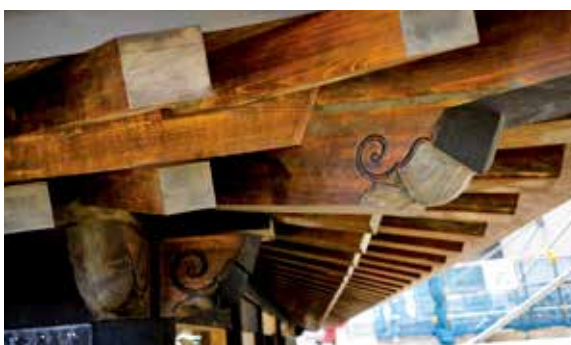
首里城正殿復元整備工事／塗装工事(国営沖縄記念公園事務所提供)
