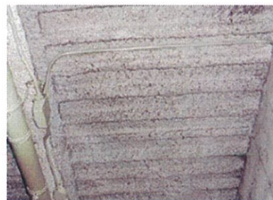
吹付け材 ※ の例(床・天井)
