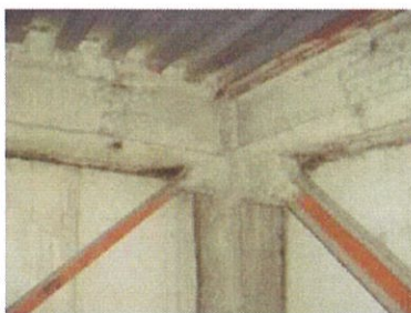
吹付け材 ※ の例(梁・柱)
